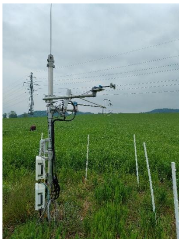
Abbildung 75. Eddy Covariance Flux Tower zur Messung der Stoffflüsse
